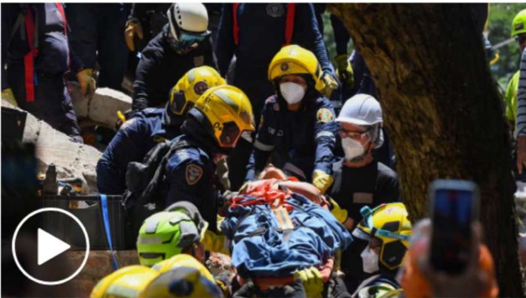
Personal de rescate logran sacar con vida a Diana Lucia en un edificio colapsado en Cali, Colombia. EPV
